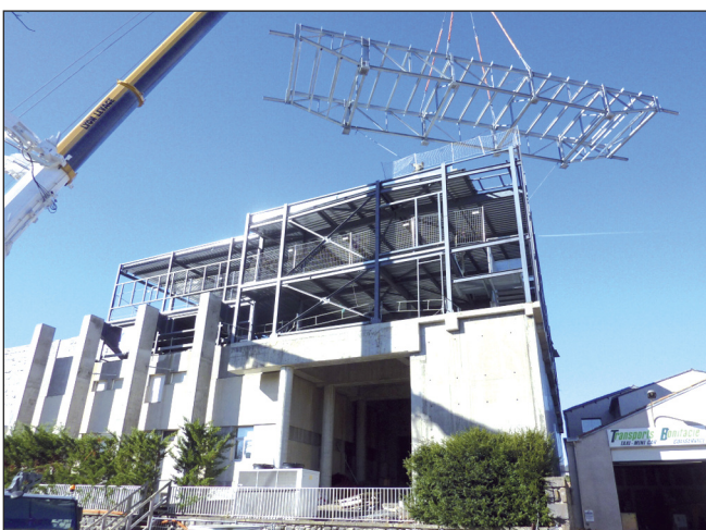
Le chantier de l'héliport, pour l'hôpital de Saint-Flour (photo Anthony Le Goff).
