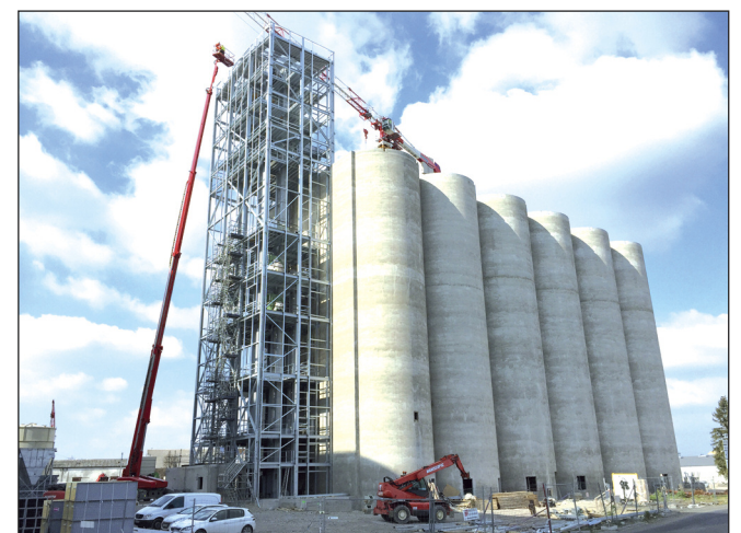
Pour Limagrain à Saint-Beauzire, CMF Structures a réalisé une extension du parc de silos (photo Anthony Le Goff).
